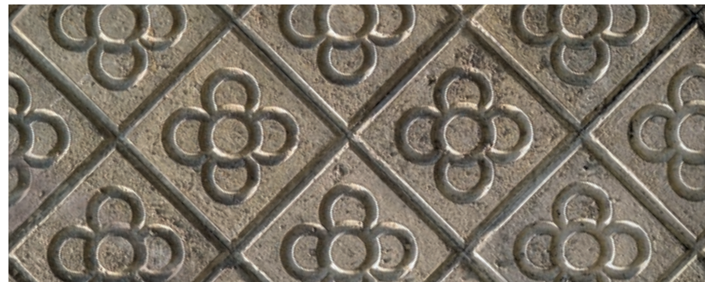
↑ Barcelona. Panots hidràulics (c. 1907) de la fàbrica Escofet. Autor desconegut.
