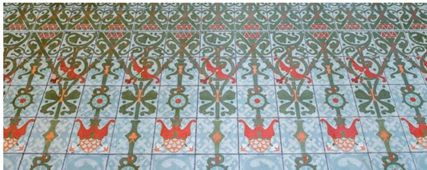
Barcelona. Casa Lleó Morera (1905), de Domènech i Montaner. Paviment hidràulic d'una habitació del pis principal. ↑
