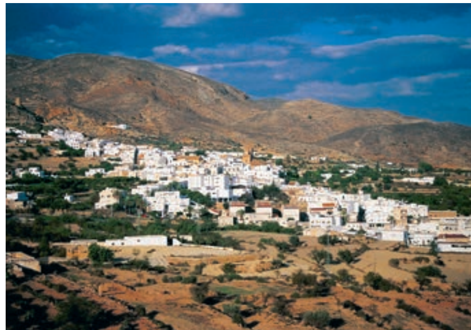
Vue générale de la ville de Níjar
