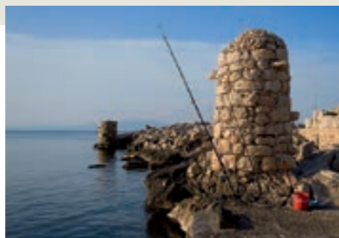
Amarraderos en la orilla del antiguo puerto de l'Escala. Encarado al norte, recibía los embates del levante y de la tramontana. Esto convirtió a los
